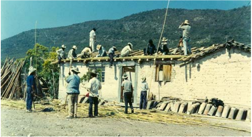
Construyendo un techo nuevo.
