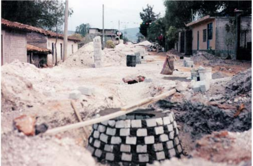
Construyendo el sistema de drenaje del pueblo.
