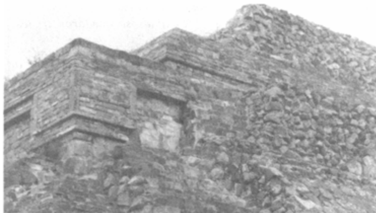
Detalle del edificio M. Monte Albán III. Foto por Don Burgess
