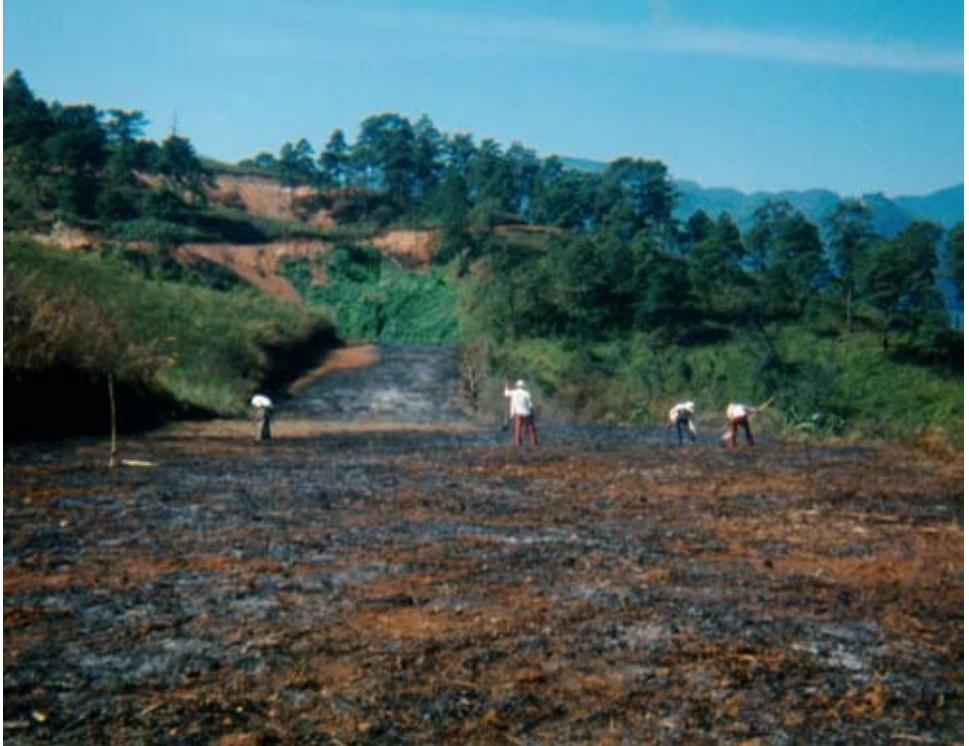
Dándole mantenimiento a la pista de aterrizaje de Comaltepec.
