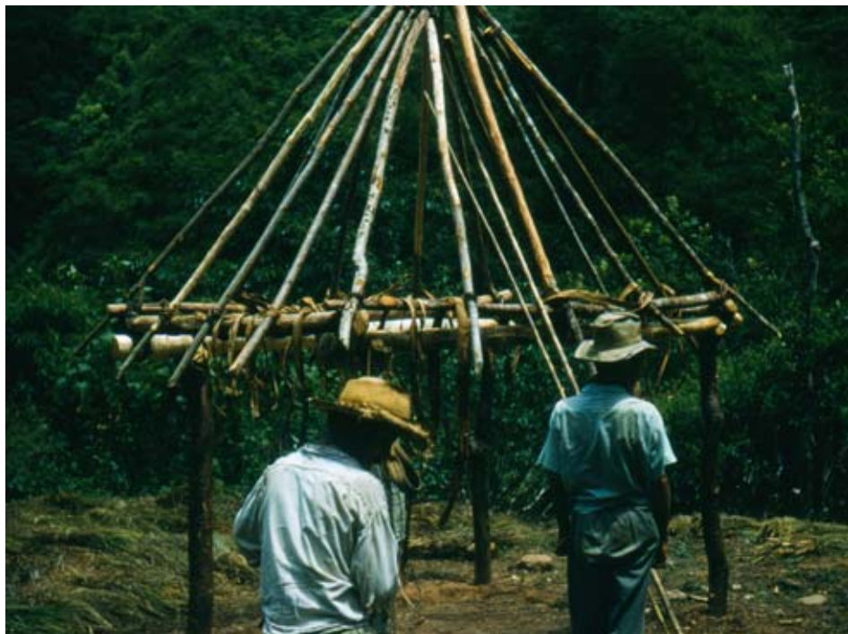
Casa bajo construcción en tiempos pasados.
